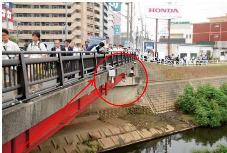
危機管理型水位計（橋梁添架）超音波式
